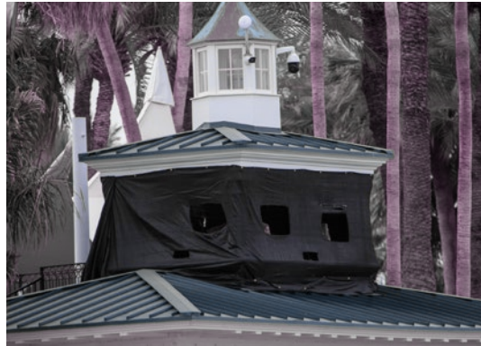
^ Fig. 135. Torre de vigilancia.
